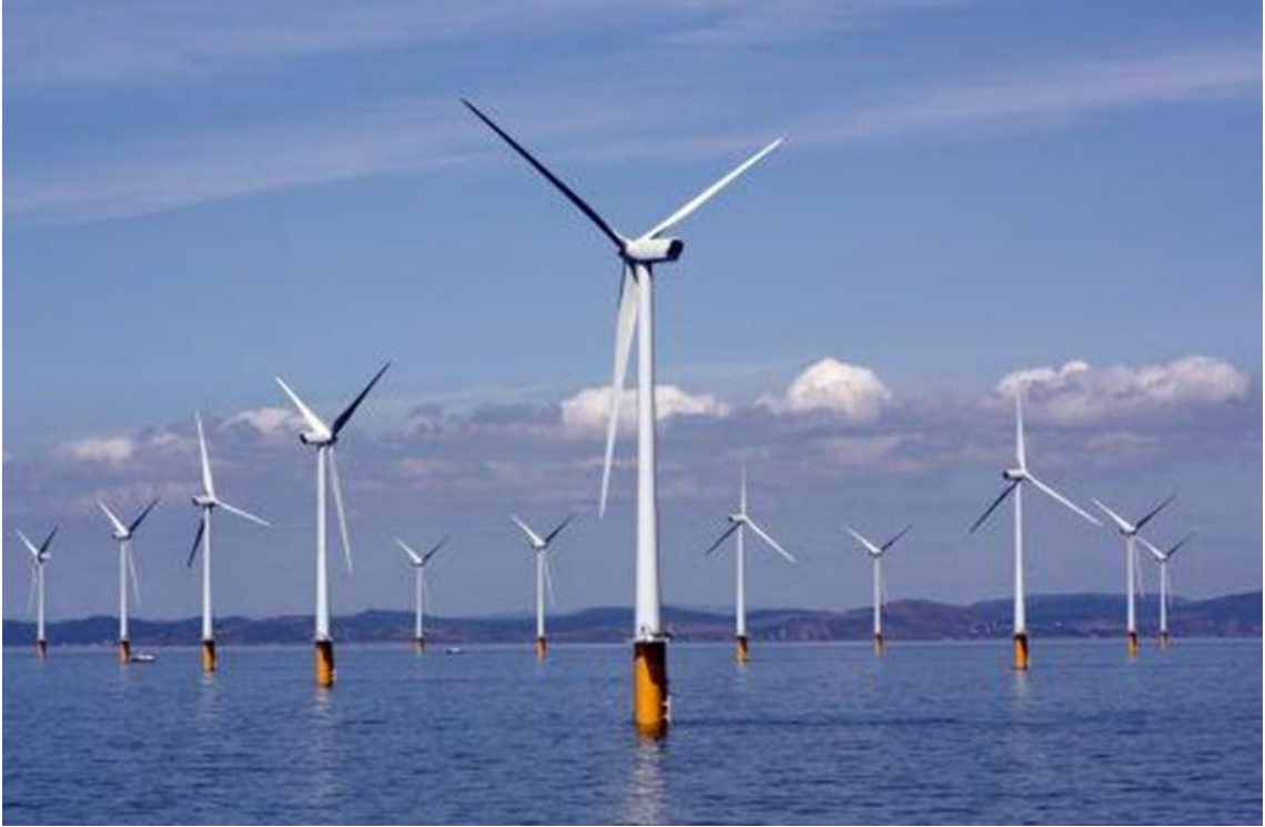
Şekil 2.1 Yatay eksenli rüzgâr türbinleri görünümü.
