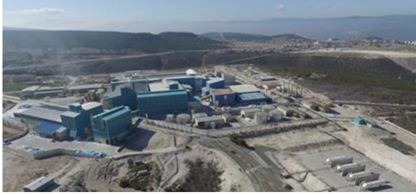
Resim 5.2 Emet bor işletme tesisi genel görünüm.
