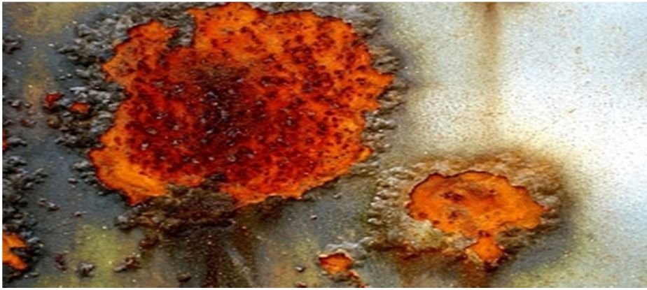
Şekil 2.1 Korozyona uğramış metal yüzeyi (İnt.Kyn.1).
