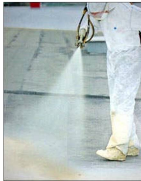
Şekil 4.2 Yüzeze poliüretan malzeme uygulaması (İnt.Kyn.5).
