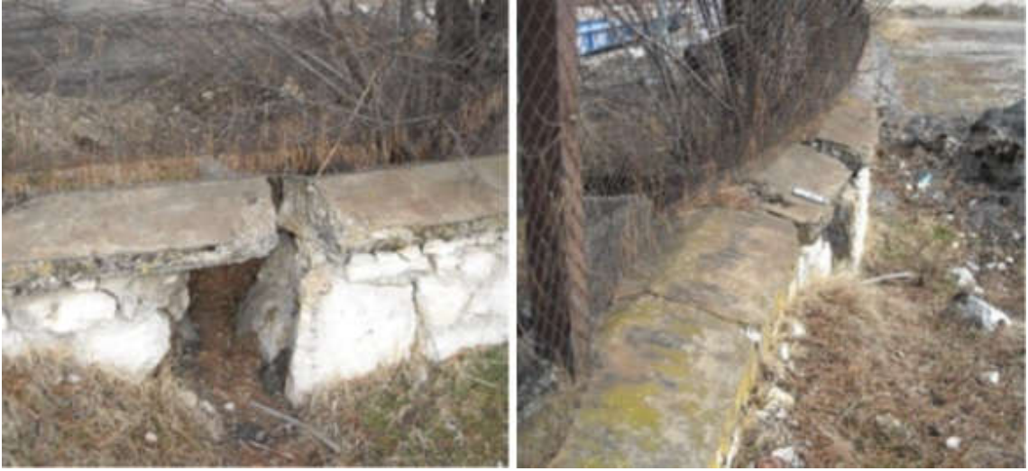
Resim 2.1 Krip hareketinin gözlemlendiği İzmitpaşa tren istasyonunda bulunan duvara ait görüntü (Görmüş 2011).
