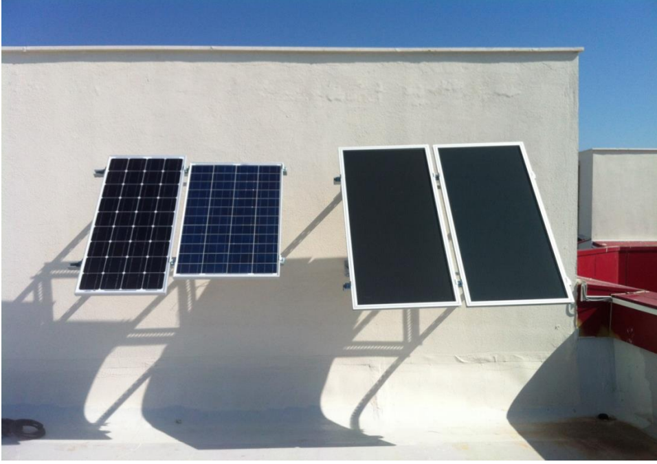
Şekil 3.25 Monokristal, Polikristal ve İnce Film tipi güneş panellerinin kurulu hali.
