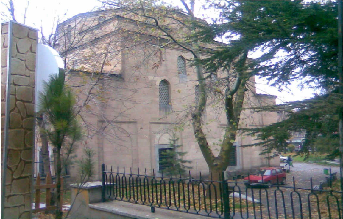
Resim 2.7 Gedik Ahmet Paşa Camii Güney Cephesinden Bir Görünüm.
