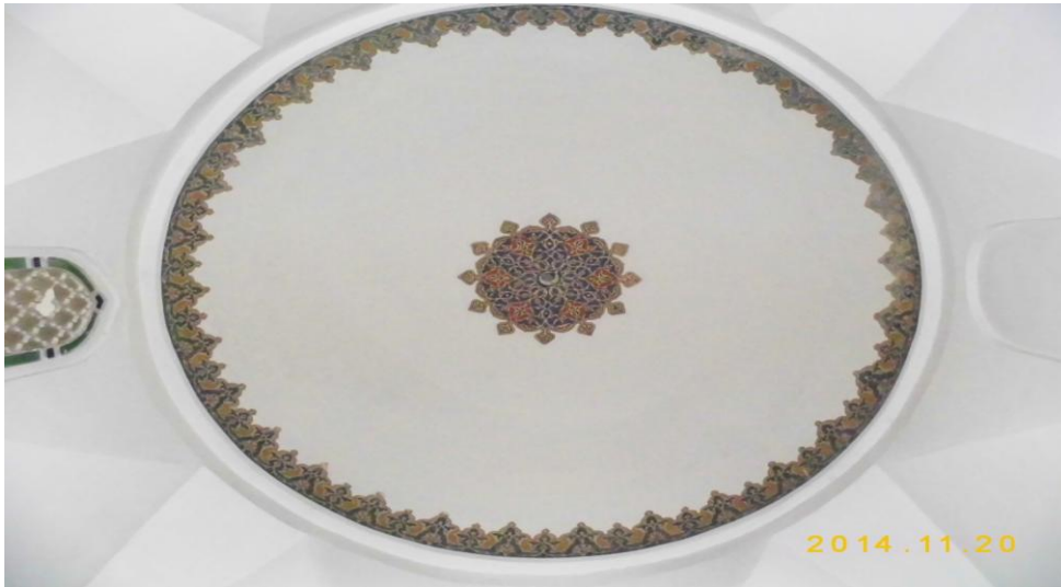
Resim 2.11 Gedik Ahmet Paşa Camii Doğu ve Batı Cephelerdeki Odalarda Bulunan Türk Üçgenleri.
