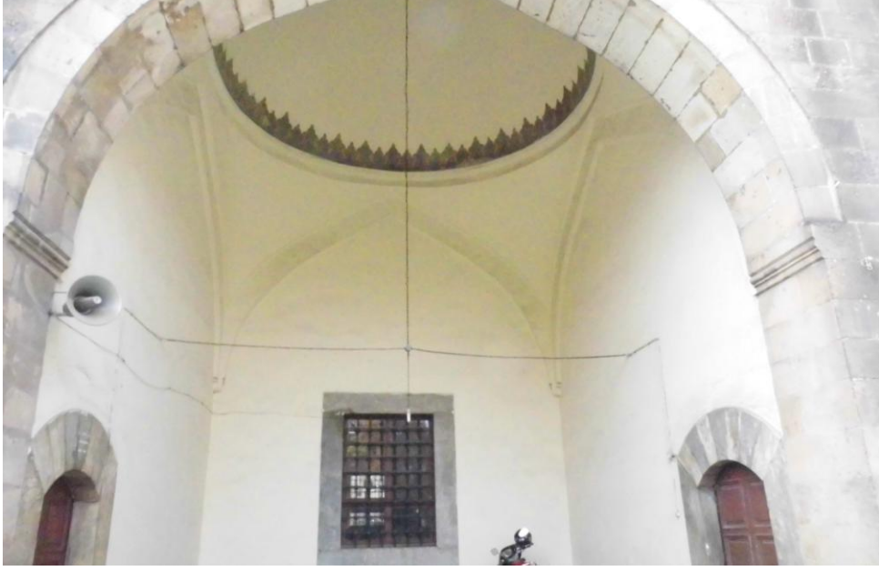
Resim 2.10 Gedik Ahmet Paşa Camii Doğu ve Batı Cephelerde Kubbelerin Oturduğu Pandatif Kemerler.
