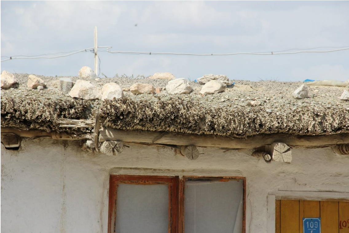
Çayıryazı köyü, Phragmites australis L. 'in çatı kaplamada kullanımı
