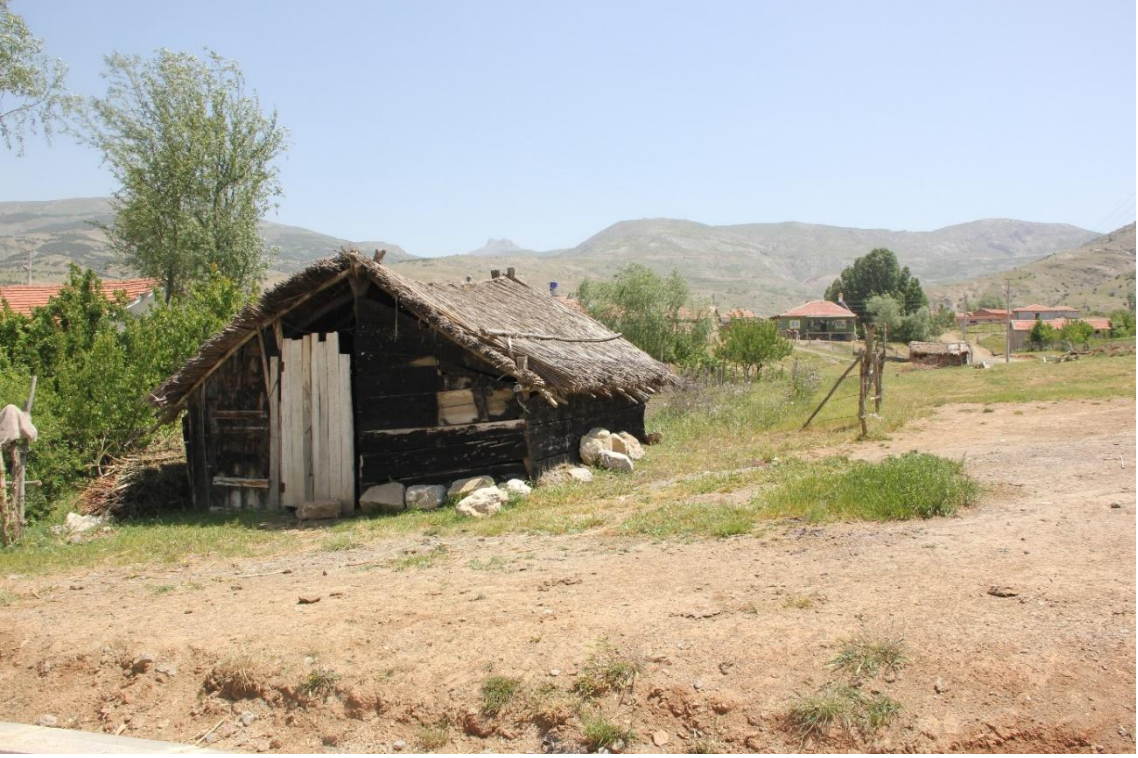
Phragmites australis L. kullanılarak yapılmış bir kulübe
