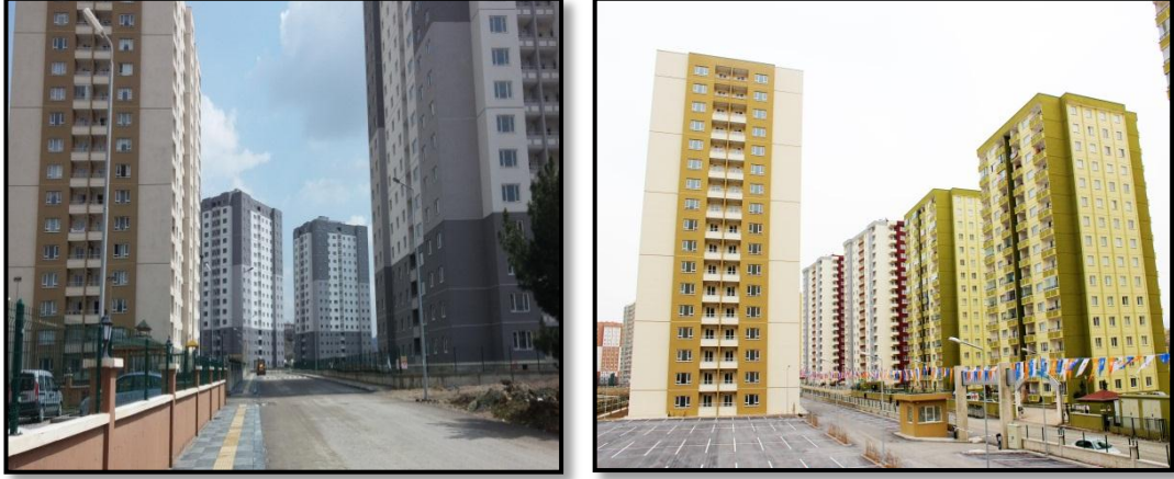
Foto 22. Hapishaneye benzetilen 1. Etaptaki Apartmanlar
