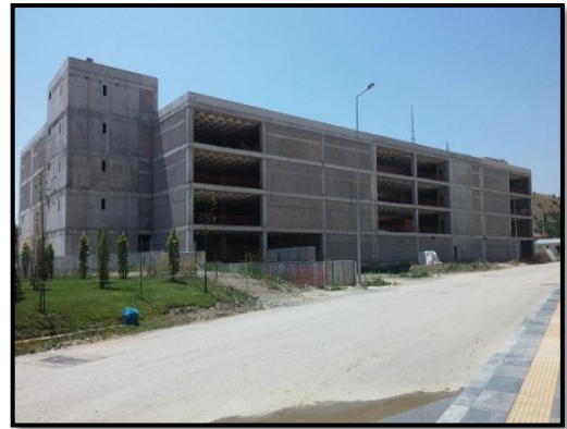
Foto 10. 1. Etap İnşaatı Devam Eden AVM
