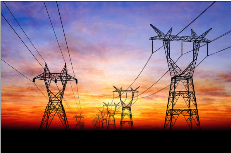
Resim 2.13 Köşebentlerden oluşan enerji nakil hattı görünümü.
