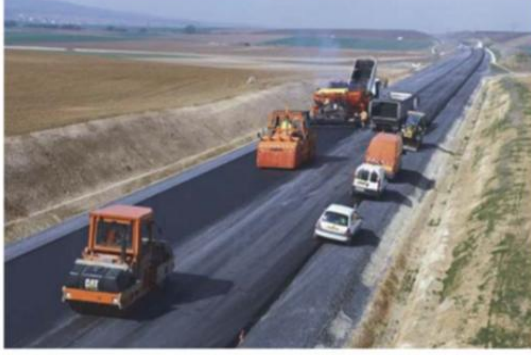
Resim 2.6 SNCF test kesimine ait asfalt tabakanın serimi ve test bölgesindeki enstrüman yerleşim planı.
