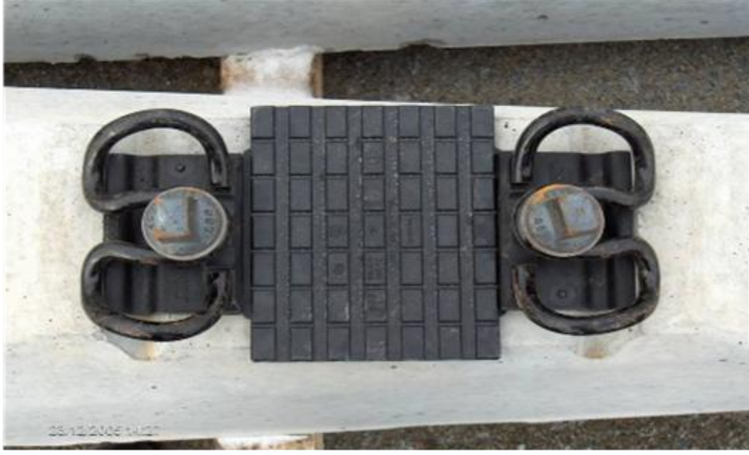
Resim 2.2 Travers bağlantı elemanları.
