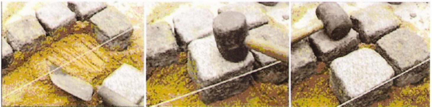
Şekil 9. Parke taşlarının yerleştirilmesini sağlamak amacıyla plastik uçlu bir çekiç kullanılması (Anon(c), 2004).
