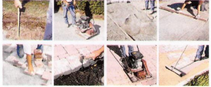
Şekil 8. Parke taşı döşeme aşamalarının görünümü (Anon(f), 2004). (Kazı, Stabilize serme ve sıkıştırma, İnce kum serme, Mastarlama, Parke taşı döşeme, Sıkıştırma, Derz dolgu kumu serme ve temizleme)
