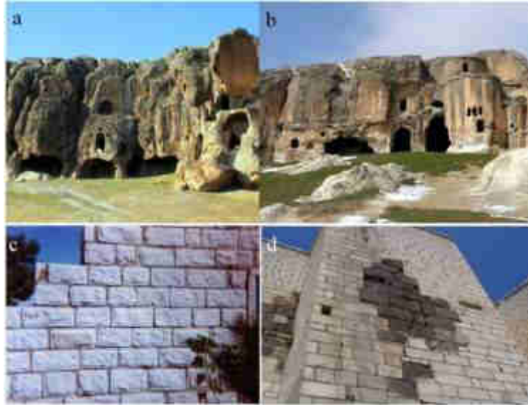
Şekil 1. Ayazini tüflerinde yapılan a) Ayazini kaya yerleşimleri, b) Ayazini Oyma kilise, c) güncel bir duvar, d) Afyon kalesi restorasyonu.
