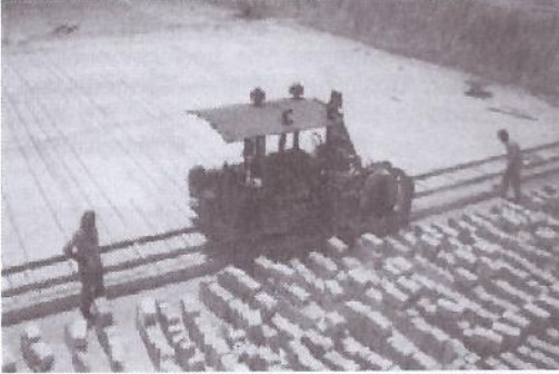
Şekil 2. Ocakta tuf blok üretiminde kesme işlemi.
