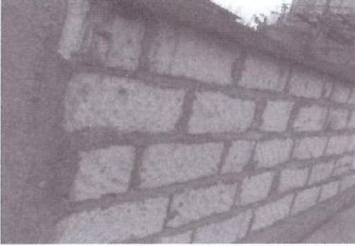
Şekil 9. Seyitgazi tufü kullanılarak yapılmış bir bahçe duvarı.
