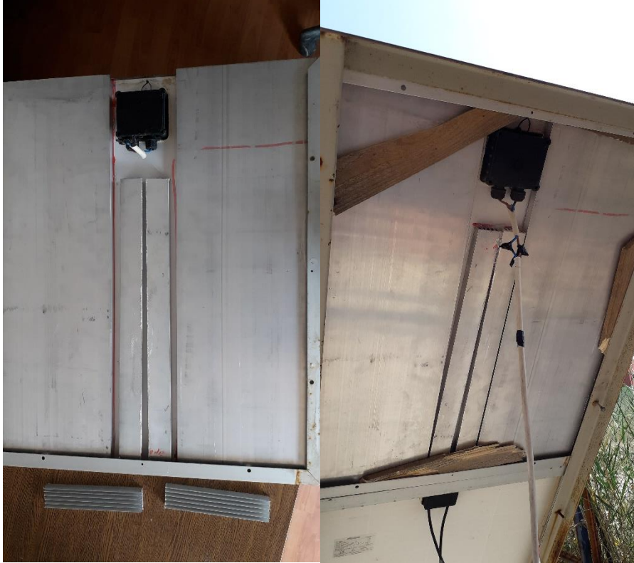
Resim 3.3 Panel Altına Yerleştirilen Alüminyum Malzeme.
