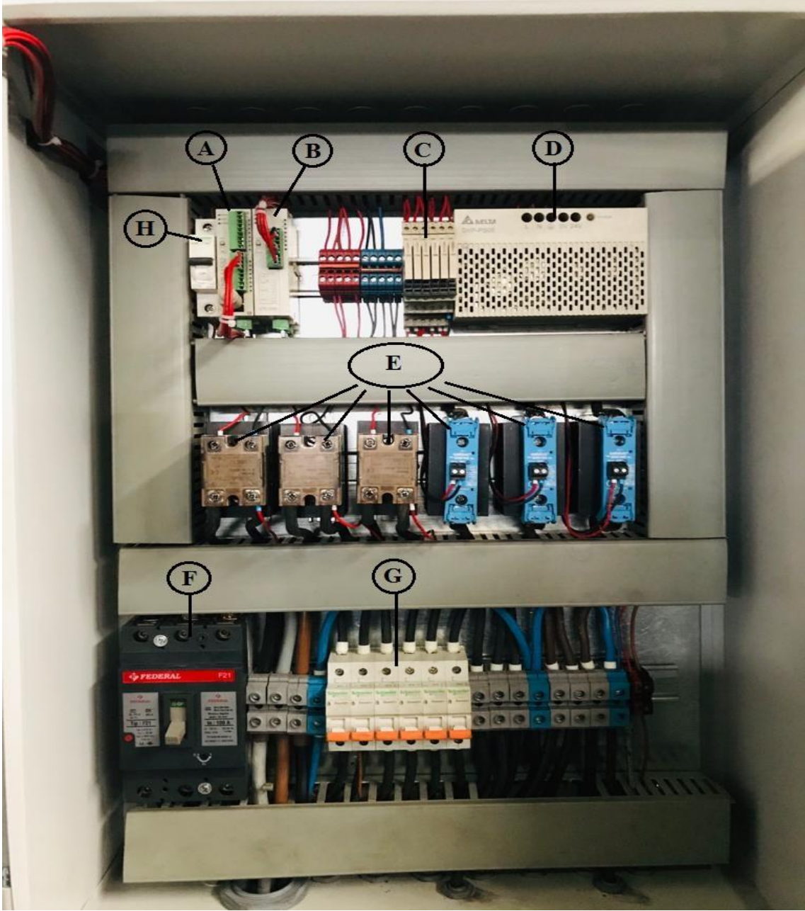
Resim 4.8 Isıl işlem fırını güç paneli iç donanım resmi.
