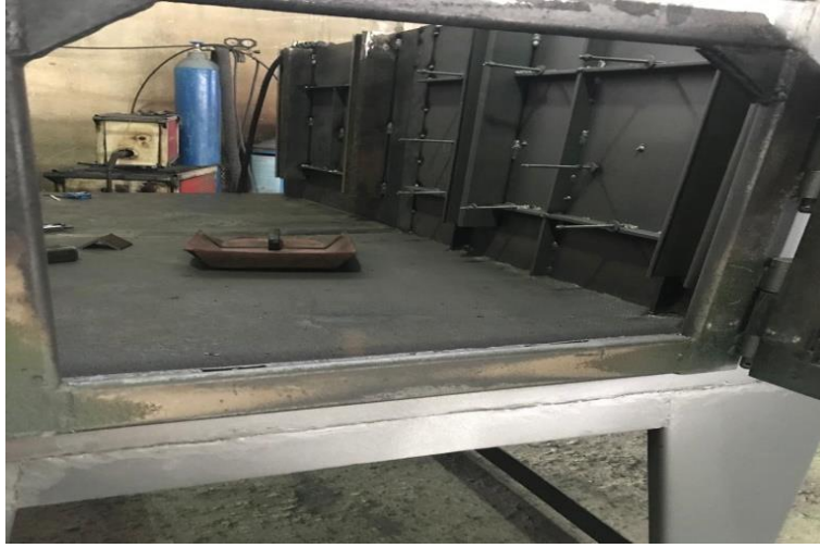
Resim 4.10 Isıl işlem fırını yan duvarı montaj resmi.
