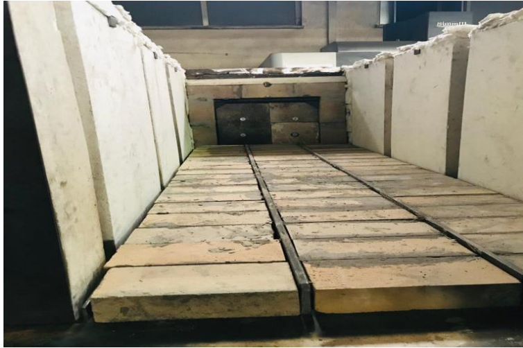
Resim 4.17 Isıl işlem fırını ateş tuğlası montaj resmi.
