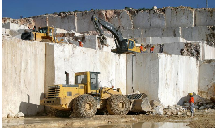
Resim 3.15 BV1 kireçtaşı ocağı
