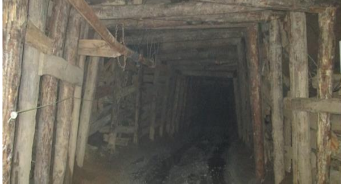
Resim 3.2 Ocak ağzı tahkimatları.
