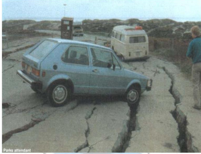
Şekil 2.13 1989 Loma Prietadepreminde devlet parkı yakınında oluşan yanal yayılma (Mollamahmutođlu ve Babuđu 2006).
