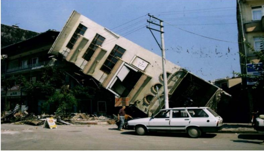
Şekil 2.16 1999 Marmara depreminde Adapazarı ilinde sıvılaşma sonucu devrilen bina.
