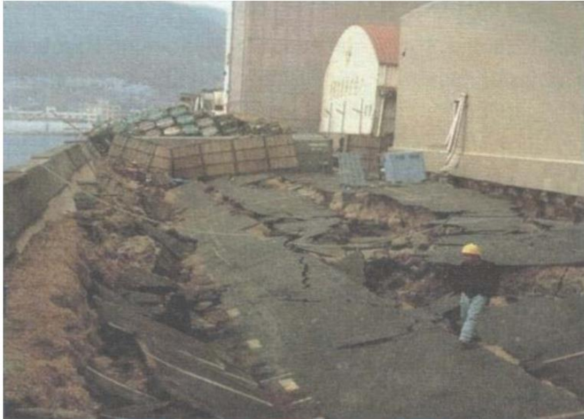
Şekil 2.14 1995 Kobe depreminde sıvılařma sonucu oluřan istinat duvarı yenilmesi (Mollamahmutođlu ve Babuđu 2006).
