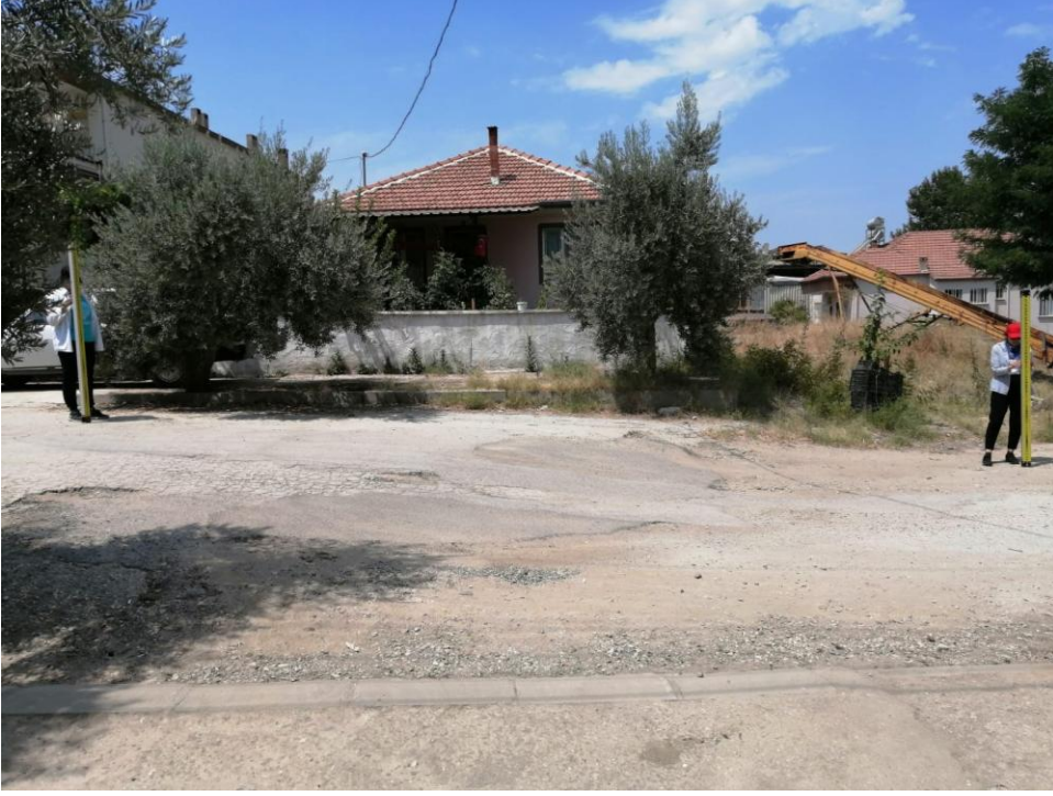
Resim 5.1 A Güzergâhı 102-103 numaralı direkler arasındaki yüzey deformasyonu (09.08.2020).
