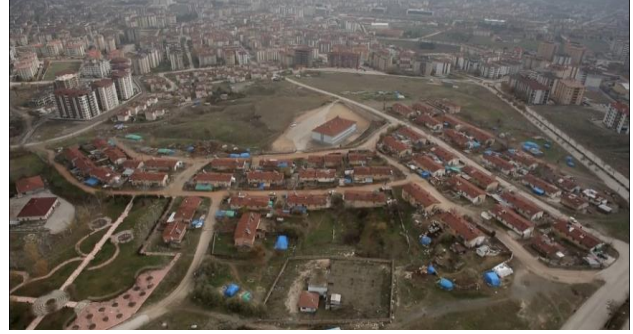
Şekil 1. Elâzığ ili Merkez ilçesi Cumhuriyet Mahallesi (Web 3)
