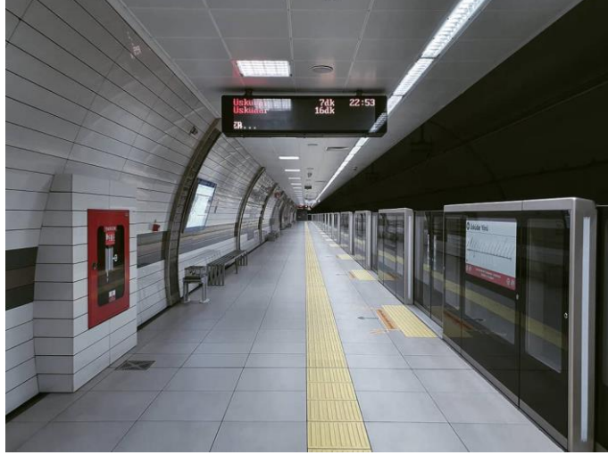
Şekil 23. Üsküdar-Ümraniye-Çekmeköy Metrosu, İstanbul (Yarım Boy Kapı Sistemi)
