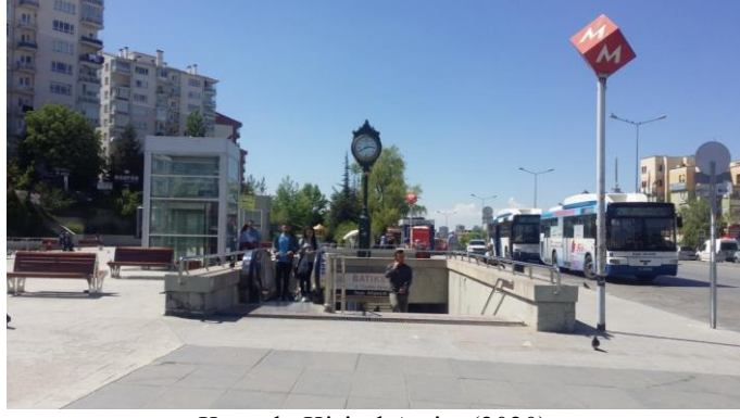
Şekil 48. Batıkent İstasyonu İstasyon Girişi
