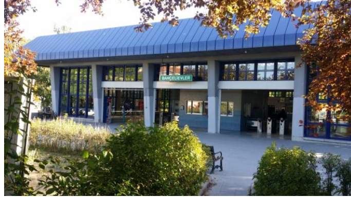
Şekil 44. Bahçelievler İstasyonu İstasyon Girişi
