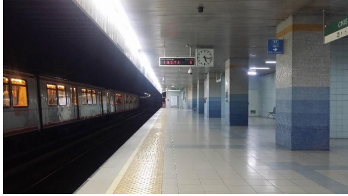
Şekil 45. Bahçelievler İstasyonu Peron Katı
