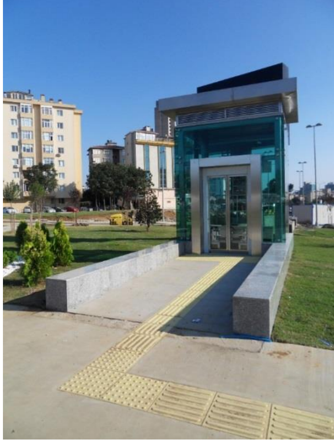
Şekil 15. Kozyatağı M4 İstasyonu Engelli Asansörü, İstanbul
