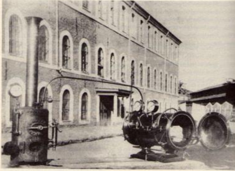
Resim 2 İçinde dezenfekte edilecek eşya ile Tersane-i Amire Fabrikalarında üretilen etüv ve su kazanı. İstanbul Üniversitesi Kütüphanesi Yıldız Albümleri, No.90921/9.
