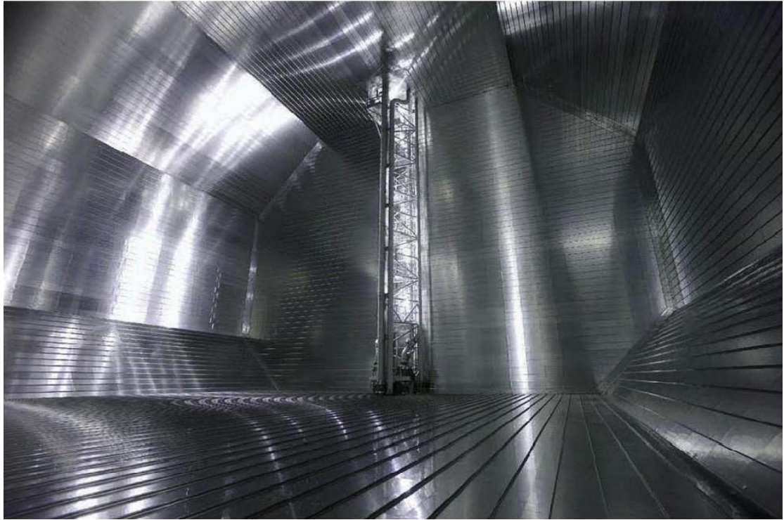
Şekil 2.11 Membran muhafaza sistemi tipi, GT NO 96 (İnt. Kyn. 5).
