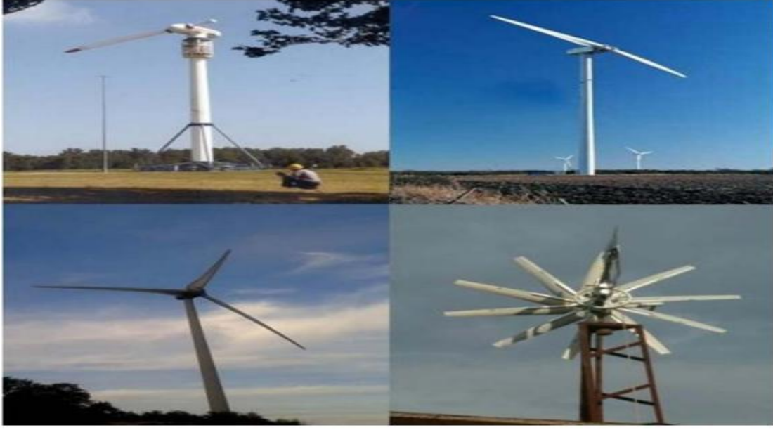
Resim 2.2 Rüzgârın gelme durumuna göre yatay türbin tasarımları(Hambarcı 2018).
