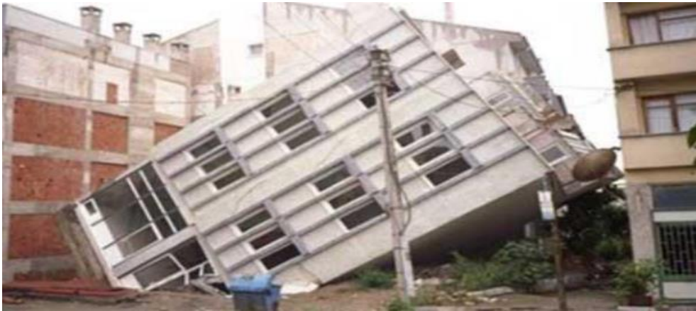
Resim 3.5 Adapazarı depreminde zemin sıvılaşma nedeniyle hasar almış bina (Gülgeç 2019).
