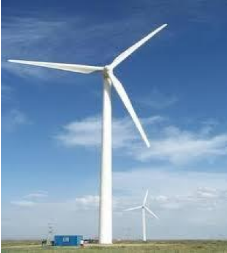
Şekil 2.1 Yatay eksenli rüzgar türbini.
