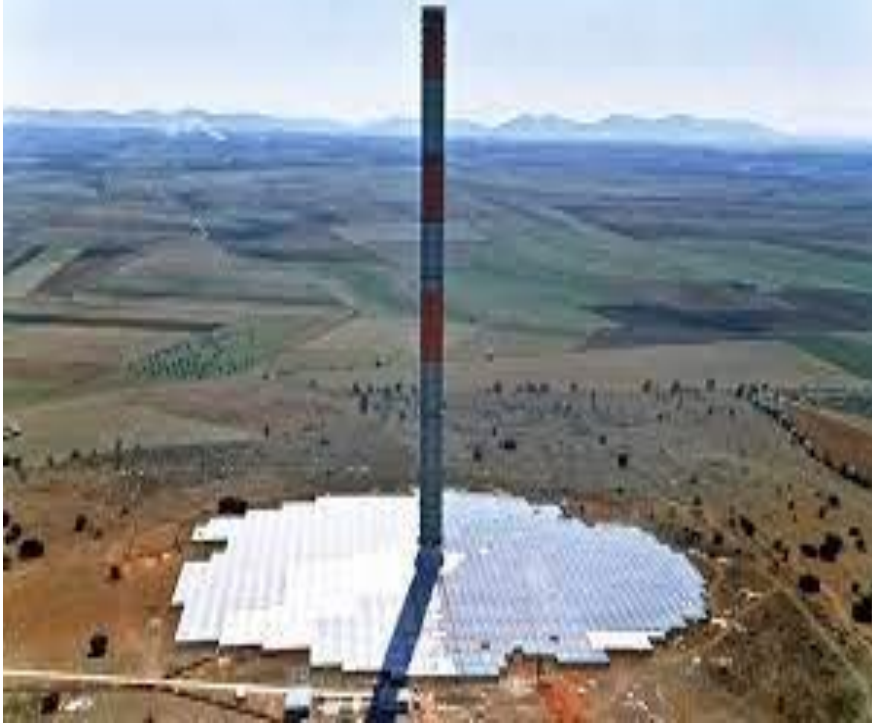
Şekil 2.3 Güneş bacası.
