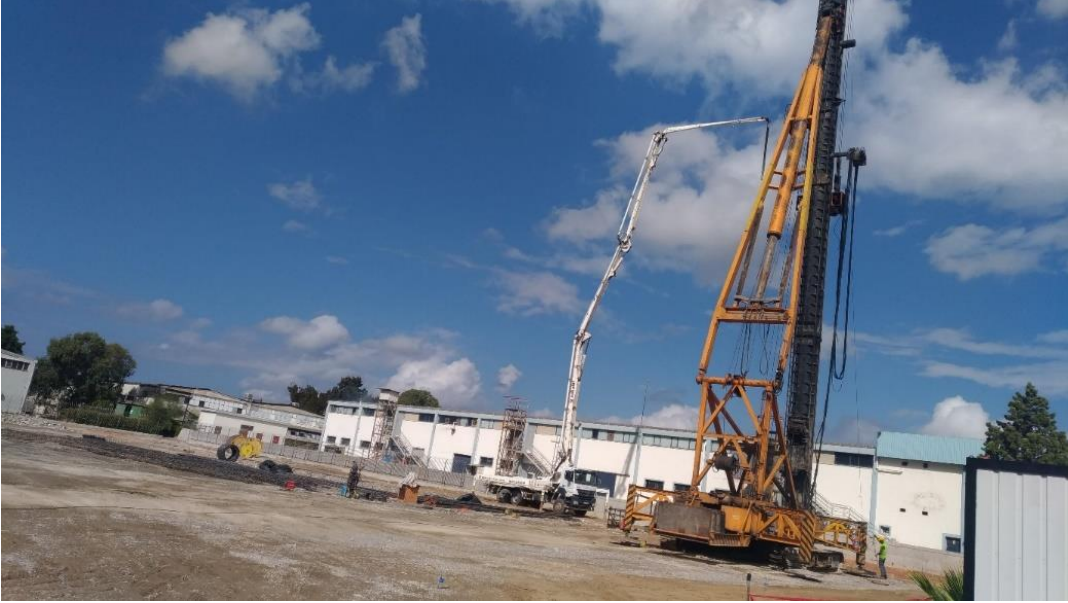
Şekil 2.8 Fore kazık uygulaması.
