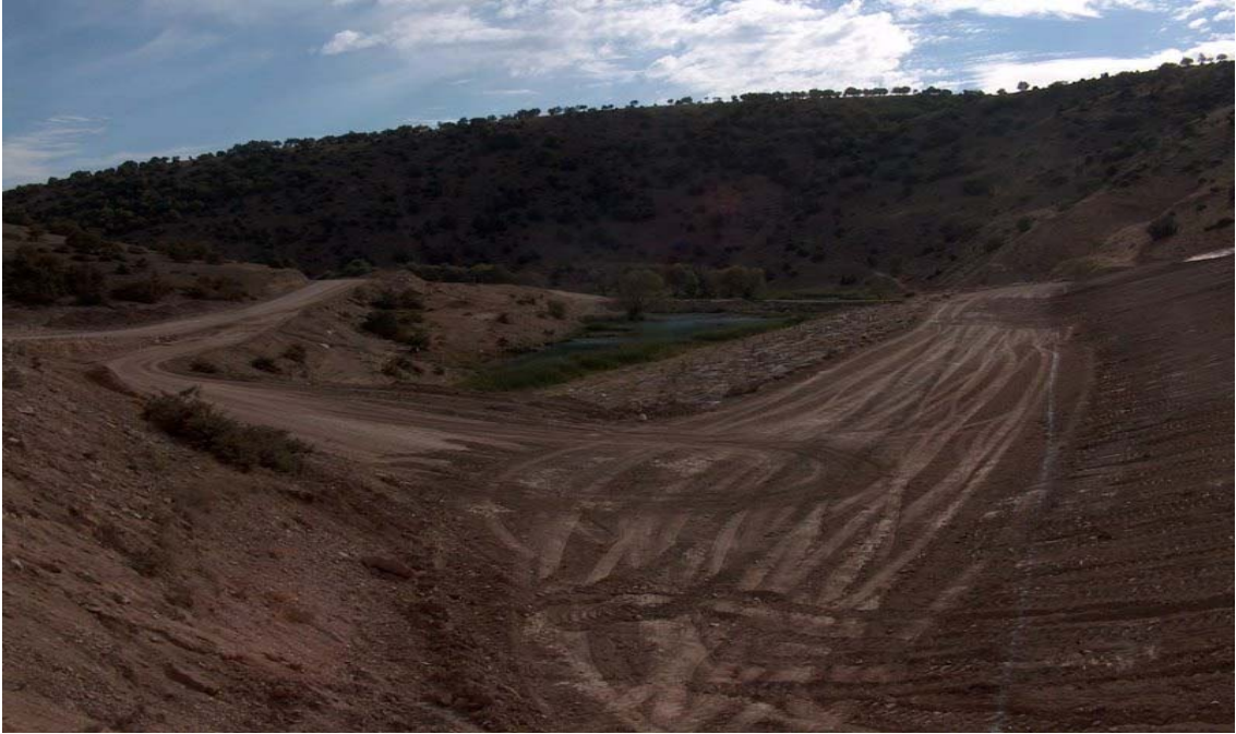
Fotoğraf 10: Beşkarış Barajı İnşaatı
