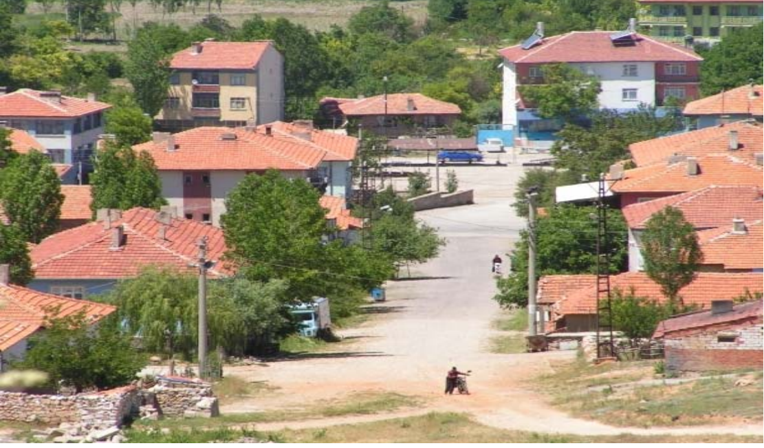
Fotoğraf 7: Altıntaş İlçesindeki Kiremit Çatılı Evler
