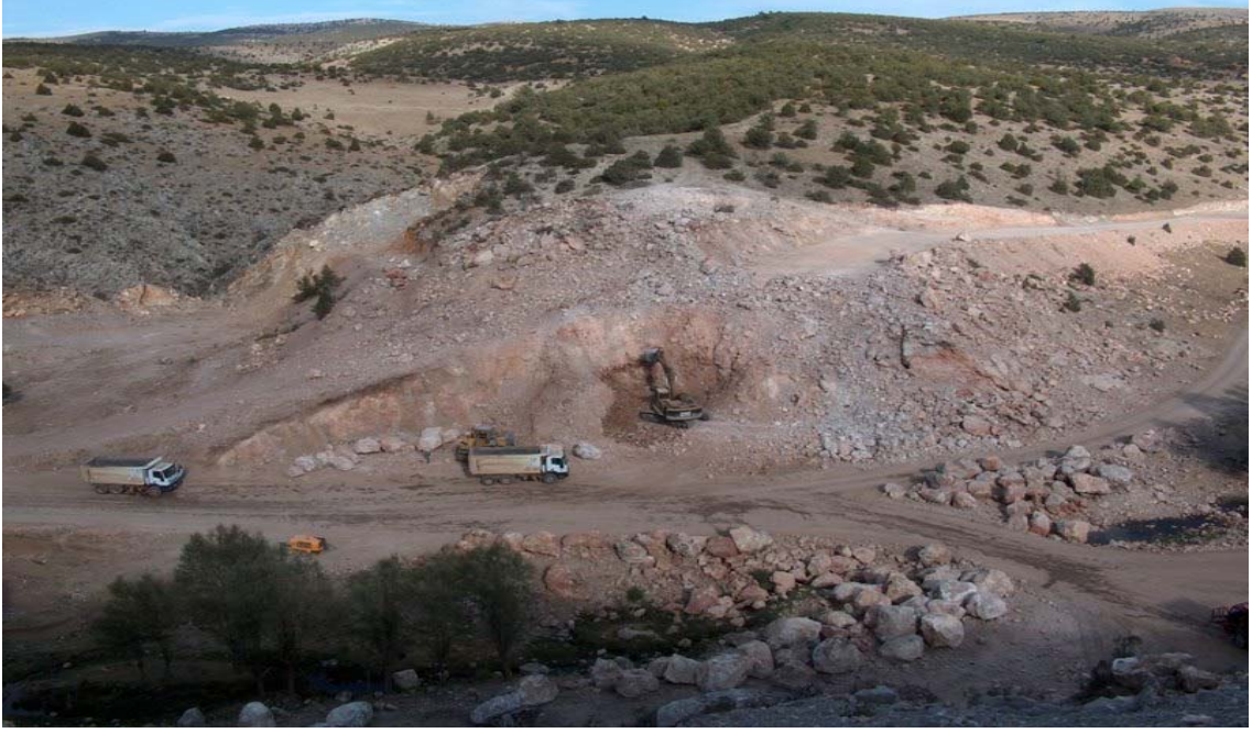
Fotoğraf 11: Beşkarış Barajı İnşaatı İçin Toprak Sağlanan Alan
