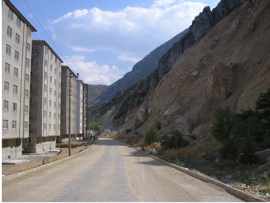
Foto 6: Şehir merkezi ile Kemik Hastanesi arasında görülen kaya düşmeleri
