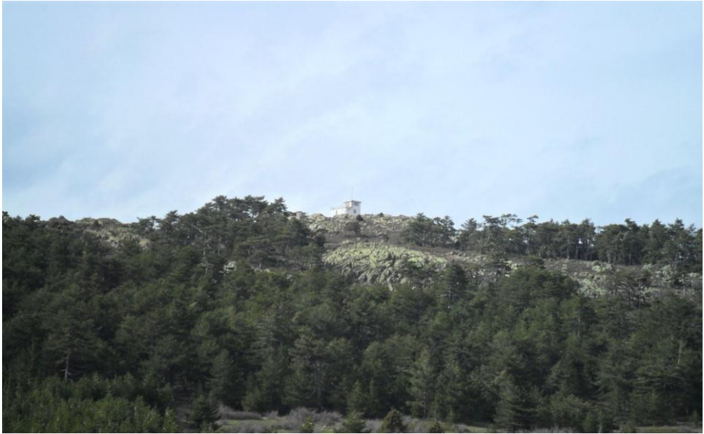
Resim 26. Yangın Gözetleme Kulesi
