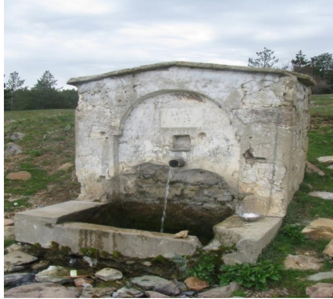
Resim 44. Pullu Oluk Çeşmesi
