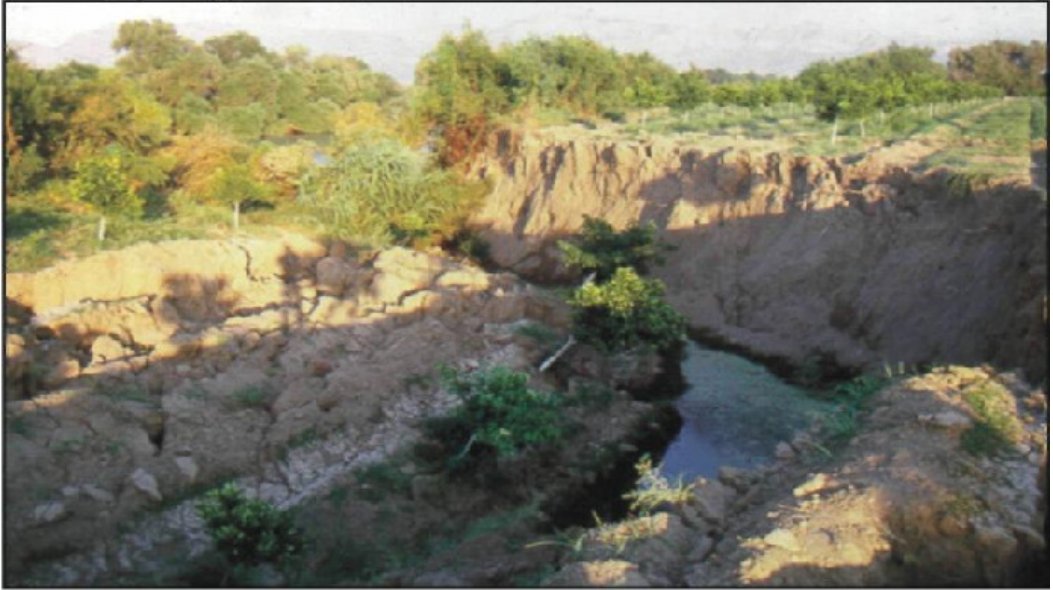
Foto 3: Abdiođlu Köyü Yakınlarında Ceyhan Nehri Kenarındaki Heyelan (Adana Valiliği İl Afet Acil Yardım Komitesi Raporu ,1998:60).
