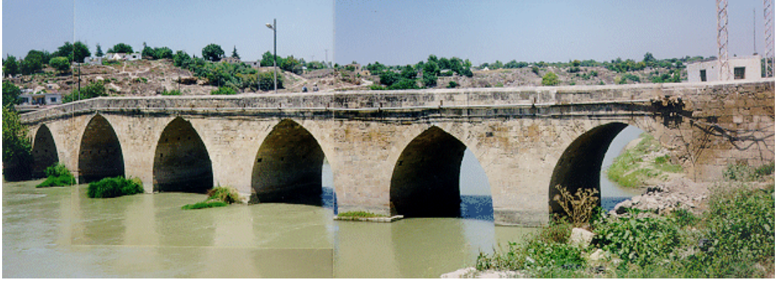
Foto 11: Misis Köprüsü (Bayülke, 1998).
