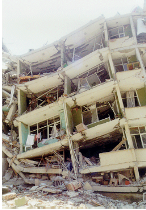
Resim 18: Yıkılmış Başka Bir Kooperatif Binası (Bayülke, 1998).
