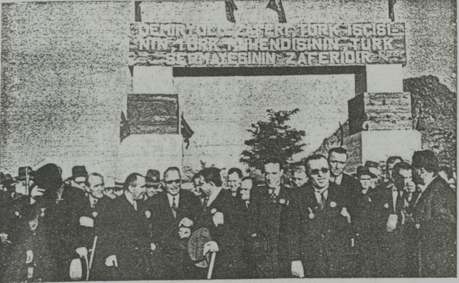
Temel atılan yerdeki tâk önünde
