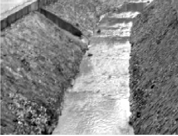
Şekil 8. Dere yatağı yamaçlarının pere kaplaması
