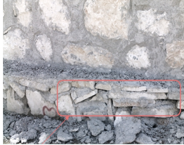
Yassı parçaların taş duvarın temel kısmında değerlendirilmesi
