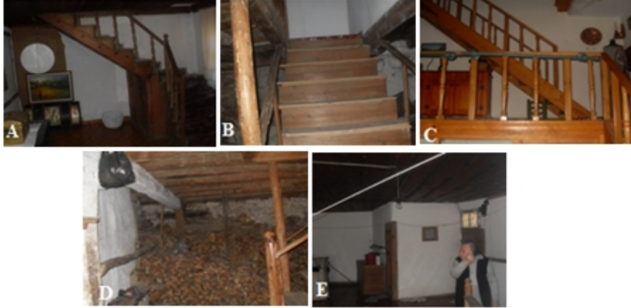
Resim 5. Göynük evlerinde merdiven detayları
