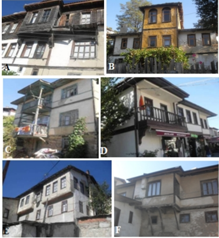
Resim 7. Göynük evlerinde çıkımlar (Ç. B. Dikmen-F. Toruk Arşivi)
