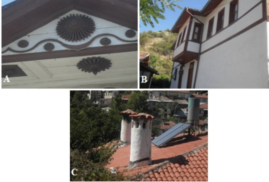
Resim 11. Göynük evlerinde çatı saçığı ve baca detayları (Ç. B. Dikmen-F. Toruk Arşivi)
