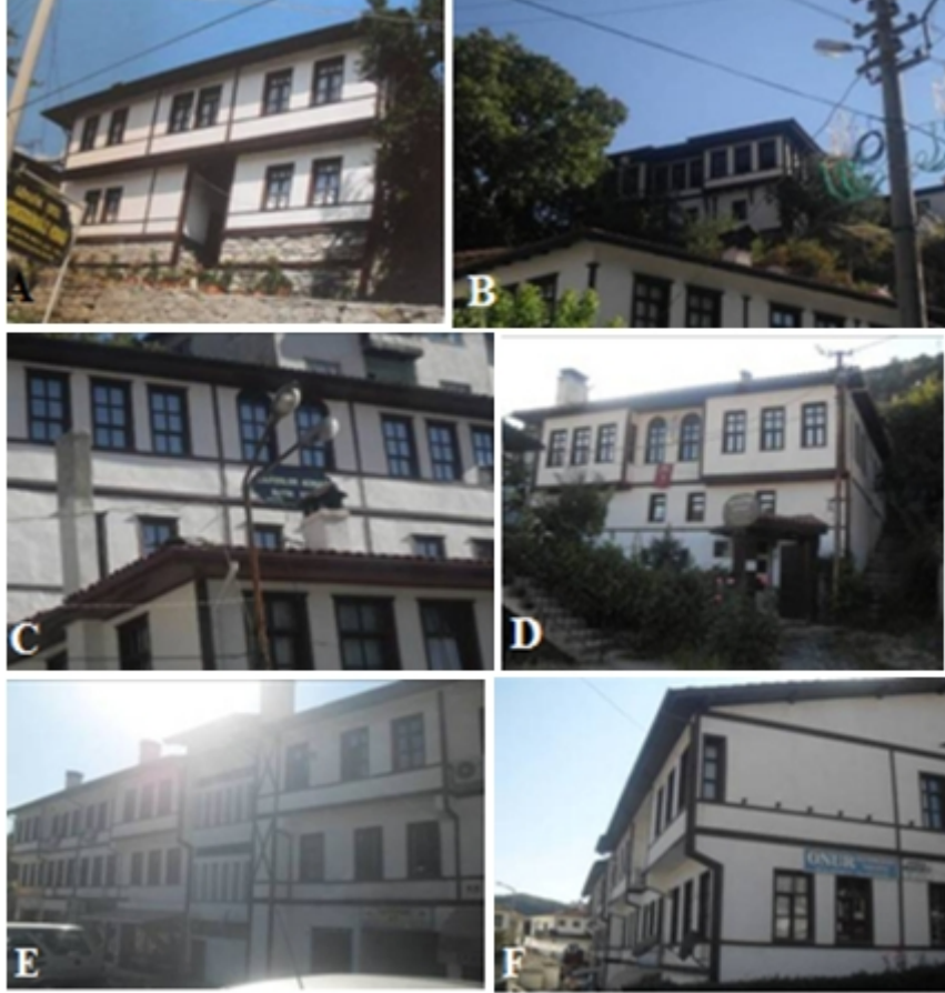
Resim 10. Göynük evlerinde kat düzeni (Ç. B. Dikmen-F. Toruk Arşivi)
