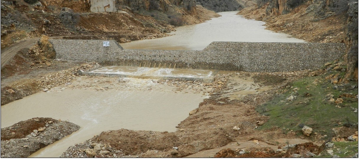
Foto 48: Kufi Çayı Tersip Benti (Kufi Çayı üzerinde inşa edilen tersip ve kesif bentleri ile taşkın ve rusubat kontrolü sağlanmıştır. Böylece Işıklı Gölü'ne taşınan malzemenin engellenmesiyle gölün dolmasının önüne geçilecektir. Foto kaynak DSİ).
