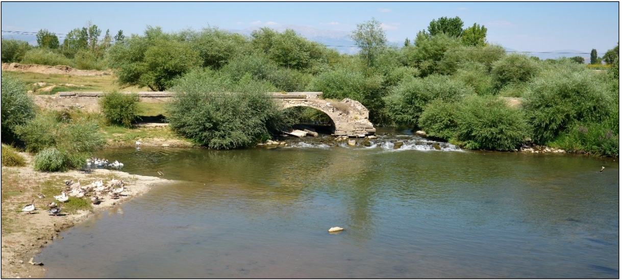
Foto 138: Çıtak Köprüsünden Bir Görünüm
