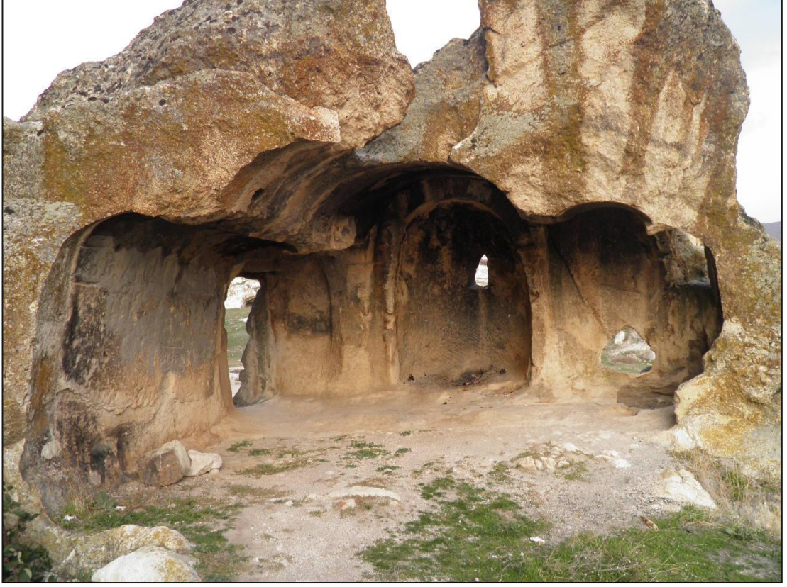
Foto 31. Metropolis Kilisesi, Yıkılan Batı Yönünden Görünüm
