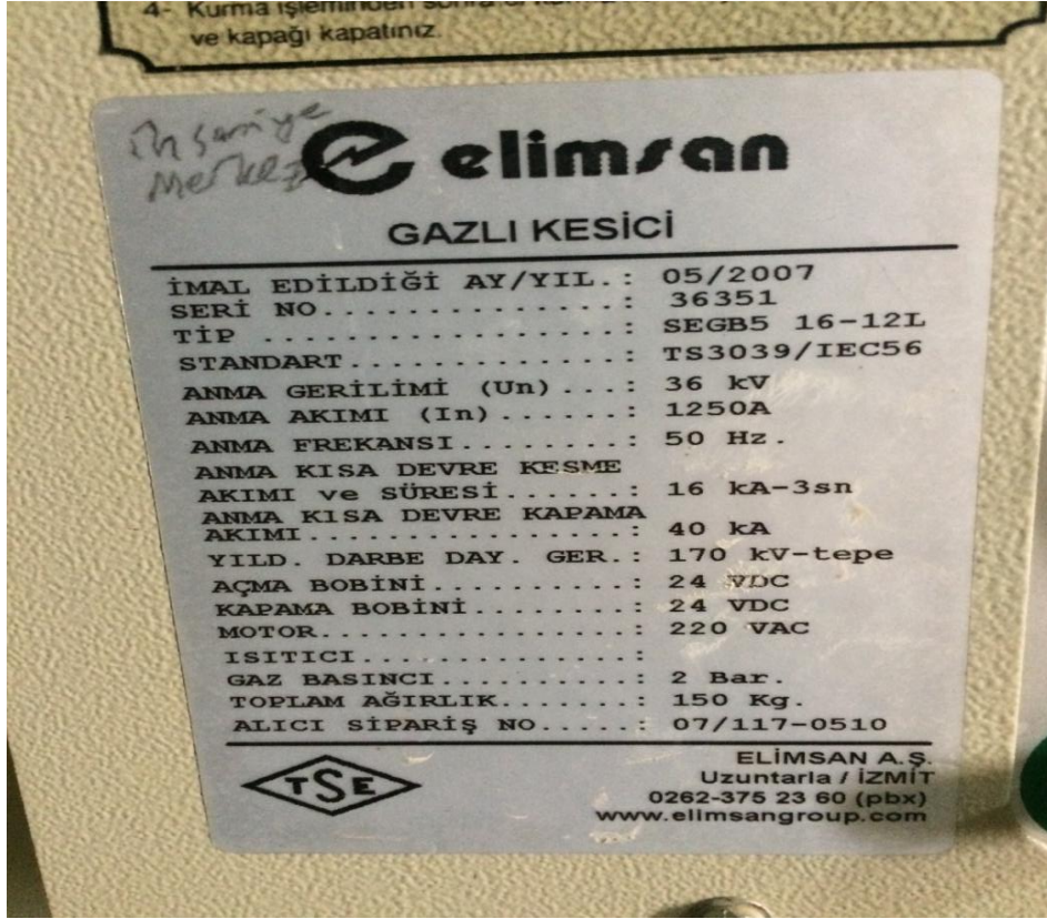
Resim 3.7 İhsaniye bölgesinde kullanılan elimsan marka SF 6 gazlı kesici etiket değerleri.
