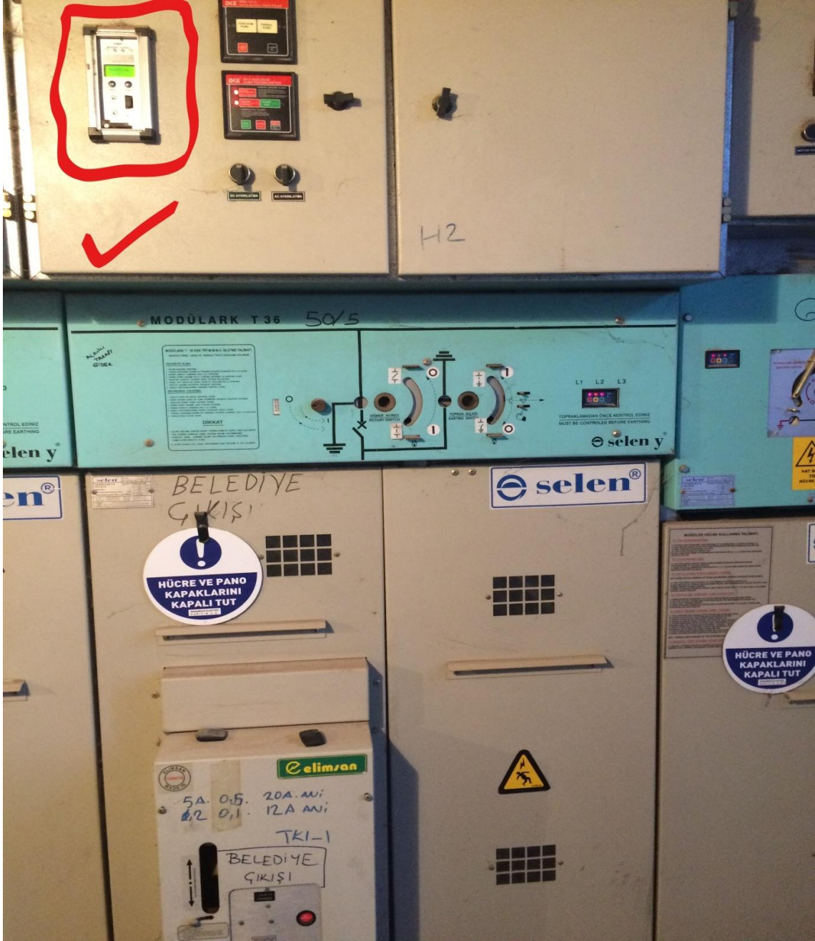
Resim 3.10 Microelettrica Scientifica röle görünümü.
