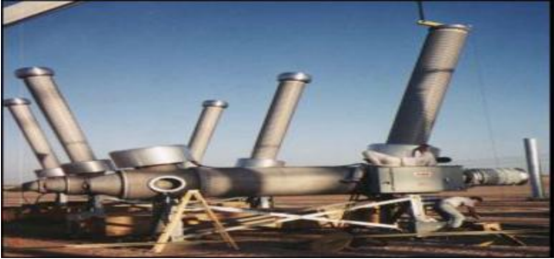
Resim 3.2 Basınçlı hava üflemeli kesici örneği (İnt.Kyn.7).
