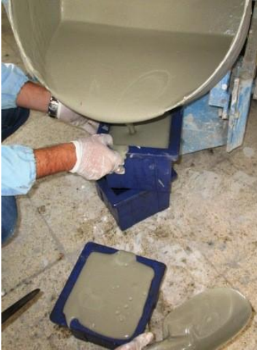
Resim 3.10 Köpük beton harcının kalıplara dökülmesi.
