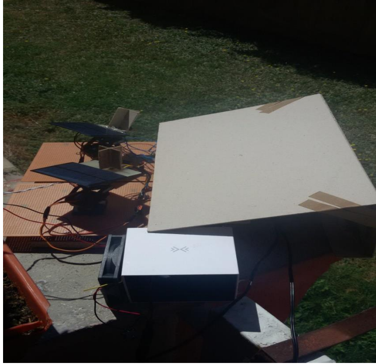
Resim 3.4 Devre elemanlarının aşırı ısınmadan korunumu ve fan tertibatı-1.
