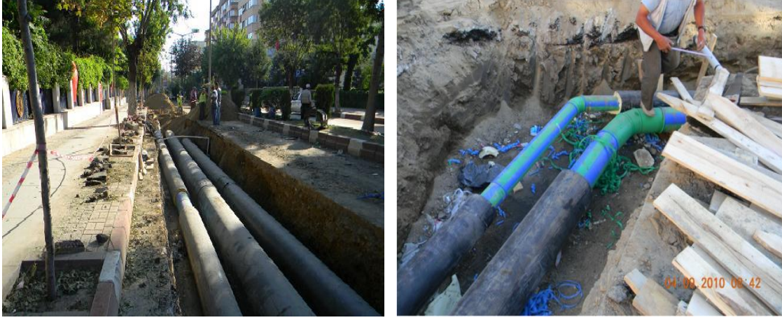
Resim 5.32 2010 yılı sonrasında gerçekleştirilen şehir içi dağıtım hattı inşaatı.
