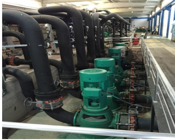
Resim 5.19 Ömer- Gecek ısı merkezindeki dik milli pompalar.
