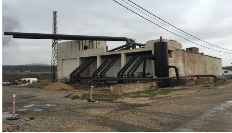
Resim 5.17 Turizm hattı jeotermal akışkan toplama havuzu ve jeotermal kuyu bağlantıları.
