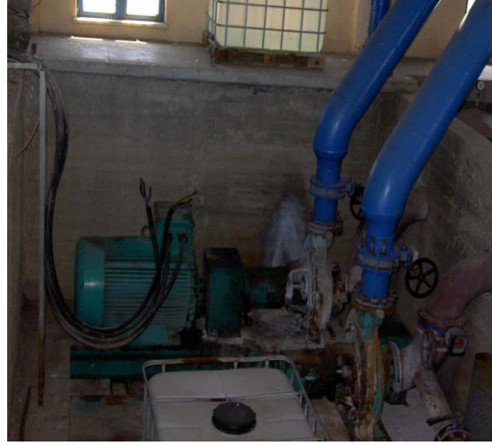
Resim 5.2. Jeotermal akışkan toplama havuzu. Resim 5.3. Toplama havuzu suyunu Karahisar ısı merkezine gönderen pompalar.
