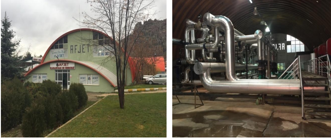
Resim 5.29 Karahisar ısı merkezinde ısı değıştirici ve dik milli pompalar.
