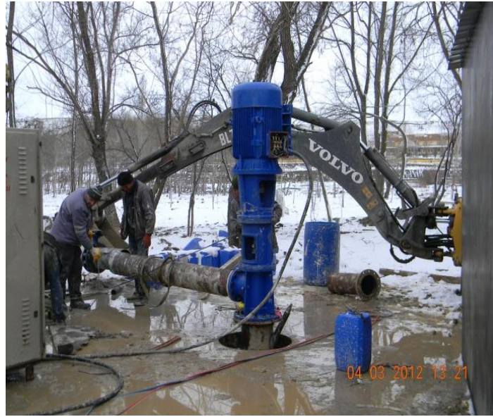
Resim 5.13 Jeotermal üretim kuyularında kullanılan dik milli pompalar.
