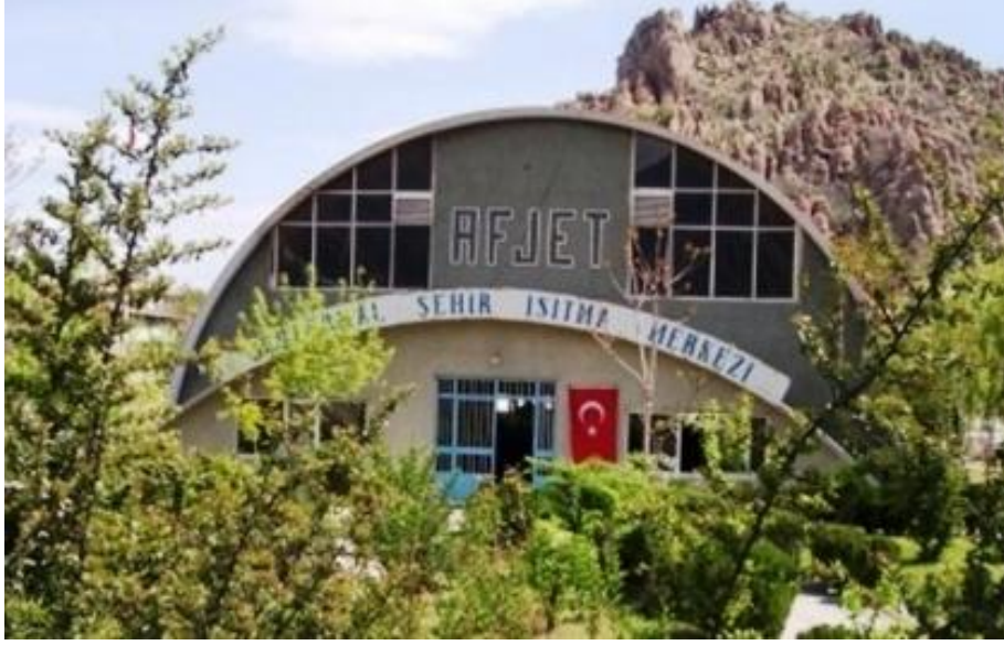
Resim 5.1 AFJET A.Ş. ısıtma tesisleri.
