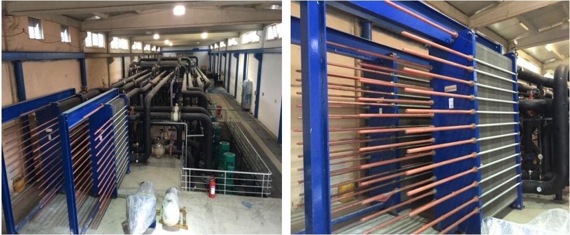
Resim 5.20 Ömer-Gecek ısı merkezindeki plakalı tip eşanjörler.
