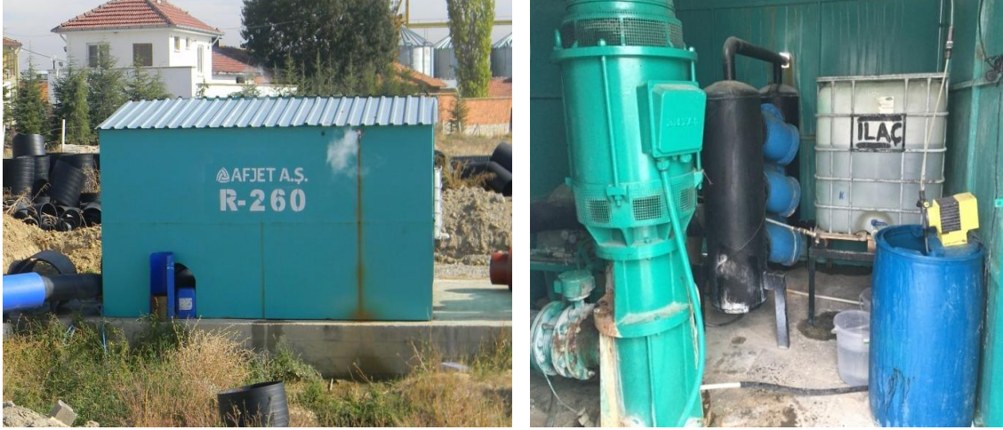
Resim 5.14 Jeotermal üretim kuyusu ve kuyu başı sistem.
