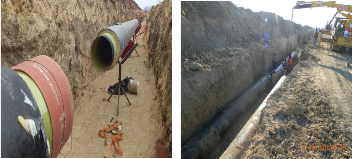
Resim 5.26 Afyon jeotermal ısı sistemi isale hattı inşaat çalışmaları.
