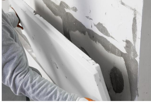
Resim 2.7 Yapıştırma harçlarının duvara uygulanması görüntüsü.
