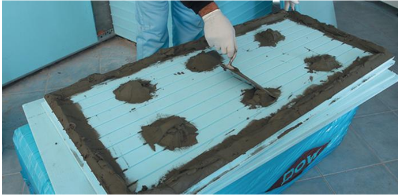
Resim 2.8 Yapıştırma harcı uygulanmış XPS görüntüsü.
