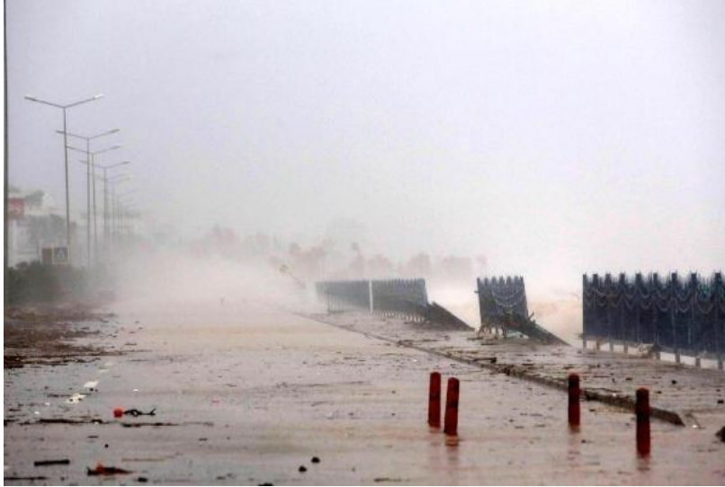
Resim 3.5 Şiddetli Fırtına ve Dalga Sonucu Konyaaltı Sahil Yolunun Durumu (İnt. Kyn. 8).
