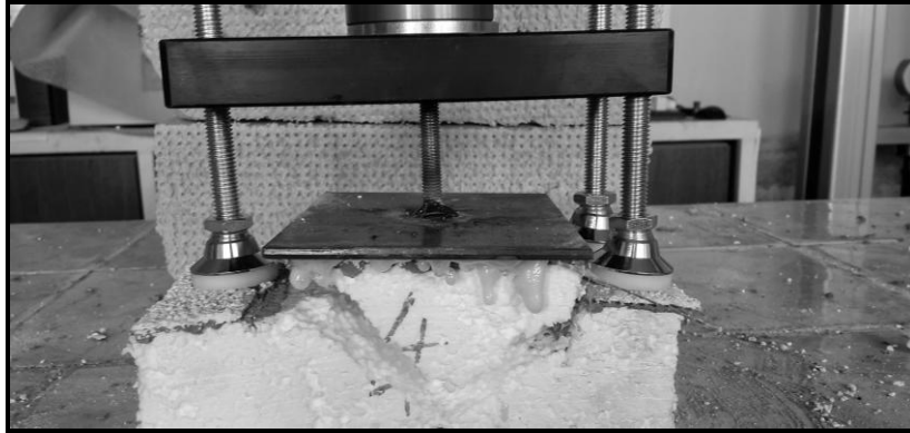
Resim 5.5 Yapışma testinde mantolama levhalarında görülen deformasyon.
