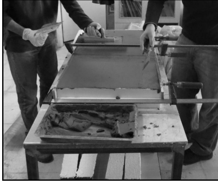
Resim 4.1. Yalıtım levhalarına sıva yapılması.
