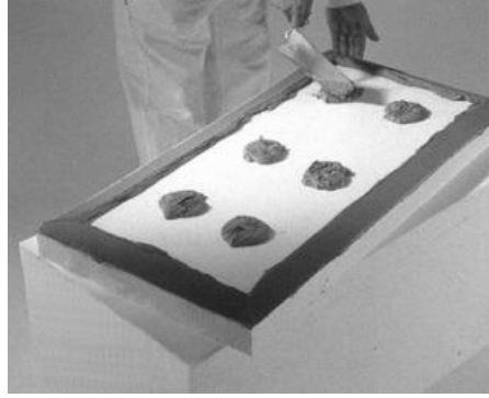
Resim 2.2 Mantolama kompozitlerinde kullanılan yapıştırma harcı.
