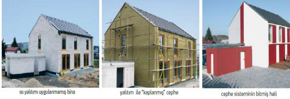
Resim 2.1 Bina dış cephe yüzeyine ETICS uygulamaları.
