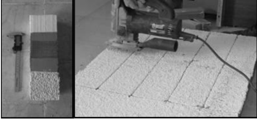
Resim 4.4 Mantolama kesiti ve sıvalı yalıtım levhasının boyutlandırılması.
