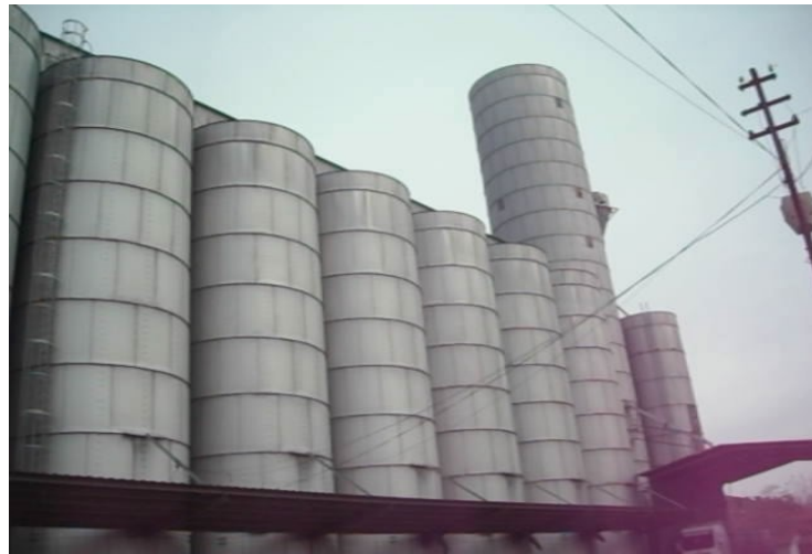
Şekil 2.3 TMO Aksaray Şube Müdürlüğü - Çelik Silolar
