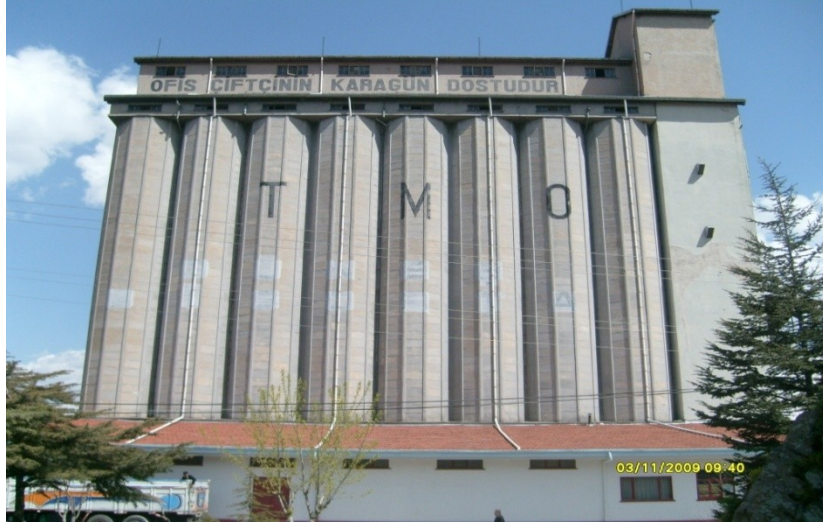
Şekil 2.2 TMO Afyonkarahisar Şube Müdürlüğü - Beton Siloları
