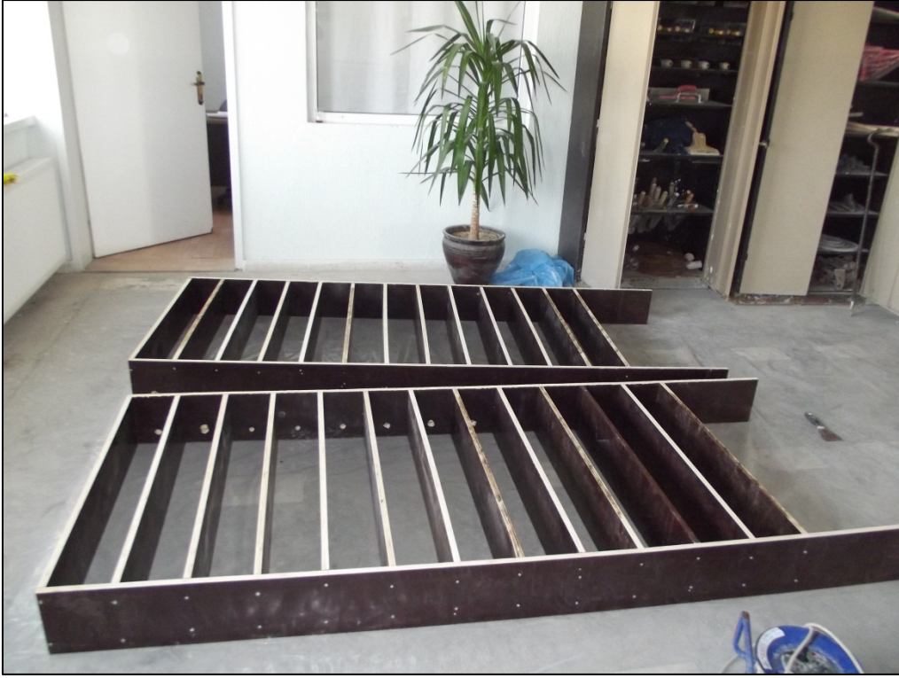
Resim 3.2 Kiriş numunelerinin için hazırlanan kalıp sisteminin görünüşü
