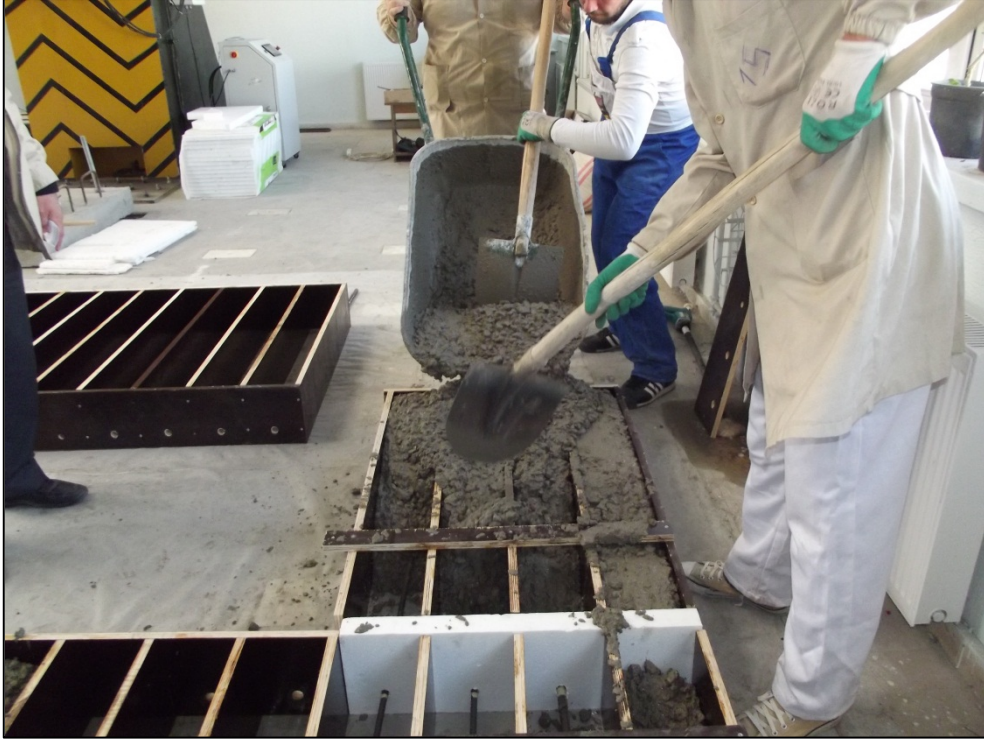
Resim 3.3 Kiriş parçalarının beton dökümü
