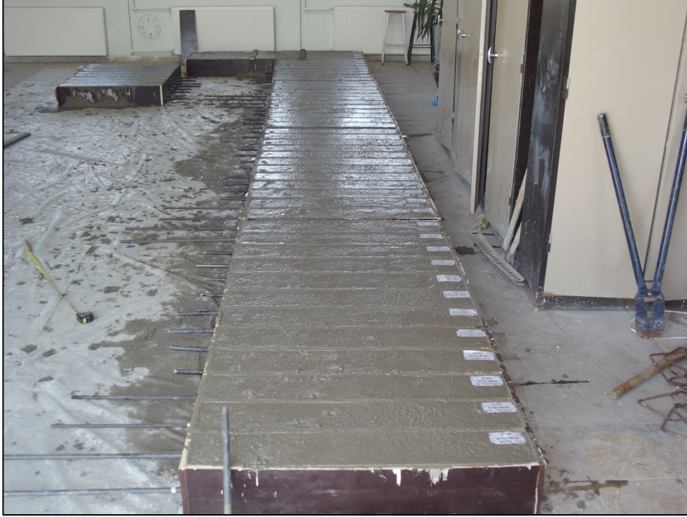
Resim 3.4 Belçika kiriş deney numunelerinin üretimi
