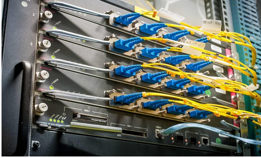
Resim 2.2 Omurga anahtarlayıcı (Backbone switch) (İnt.Kyn.10).
