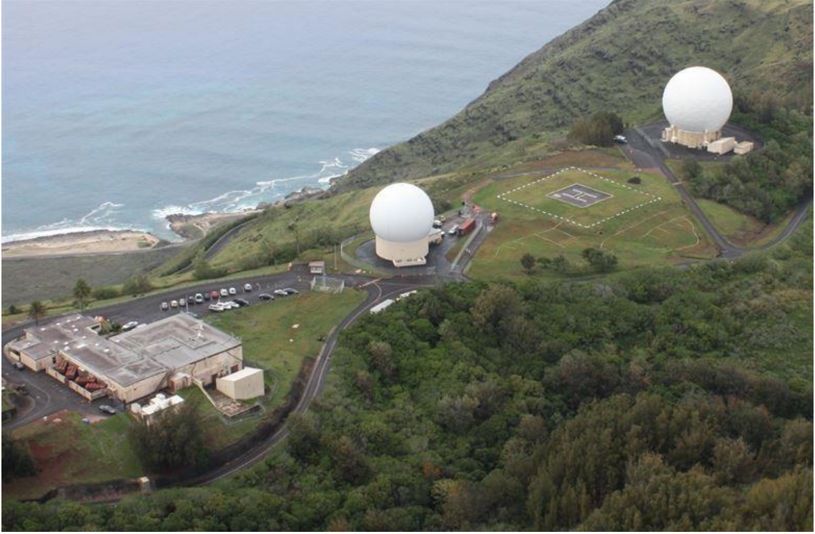
Resim 3.1 Hawaii’de bulunan Kaena Uydu İzleme İstasyonu (İnt. Kyn. 8).
