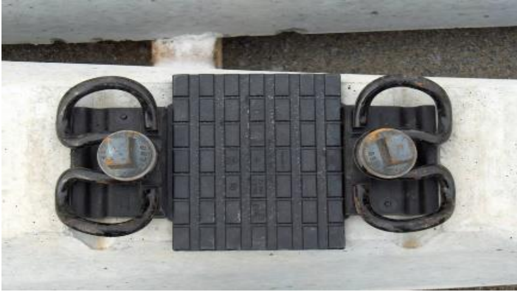
Resim 2.1 Travers ve bağlantı elemanları (Tacim 2018).
