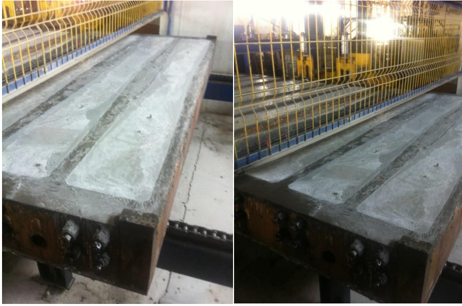
Resim 3.3 Buhar k r nden ıkan beton traversler.
