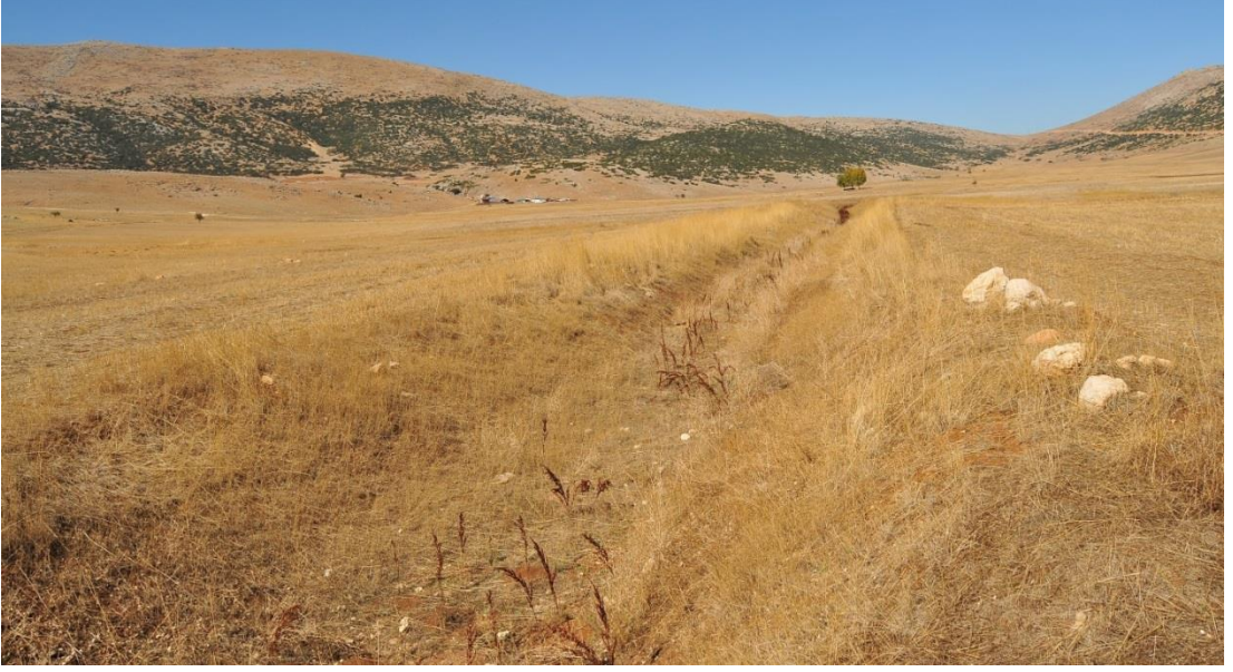
Şekil 46. Küçükemalı oluğunun ortasında tabandaki fazla suyu tahliye eden kanal bulunmaktadır. Bu kanal fazla sularını oluğun doğu kenarındaki düdene taşımaktadır.
